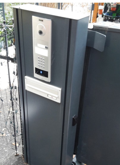
5:: Patta di inserimento in alluminio anodizzato, combinata con colonna di comunicazione
